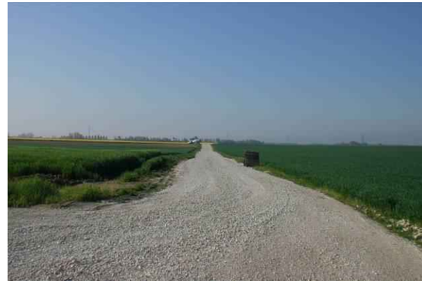
Photo 53 : Exemple de chemin d'accès après renforcement (Source : BE Jacquel et Chatillon)
