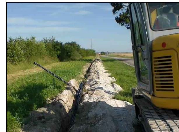
Photo 57 : Pose de câbles électriques et réalisation de tranchée à la pelle mécanique (Source : BE Jacquel et Chatillon)
