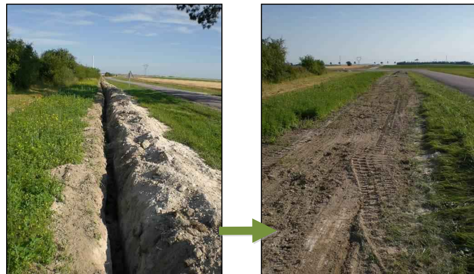
Photo 59 : Rebouchage de tranchée après passage des câbles électriques (Source : BE Jacquel et Chatillon)
