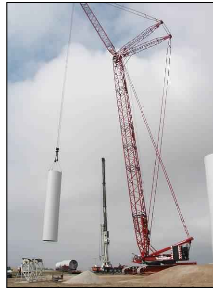
Photo 47 : Exemple d'assemblage d'un mât d'éolienne (Source : BE Jacquel et Chatillon)
