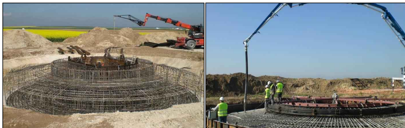
Photo 55 : Exemple de maillage d'acier d'armature pour fondation d'éoliennes de type massif poids (Source : BE Jacquel et Chatillon)
