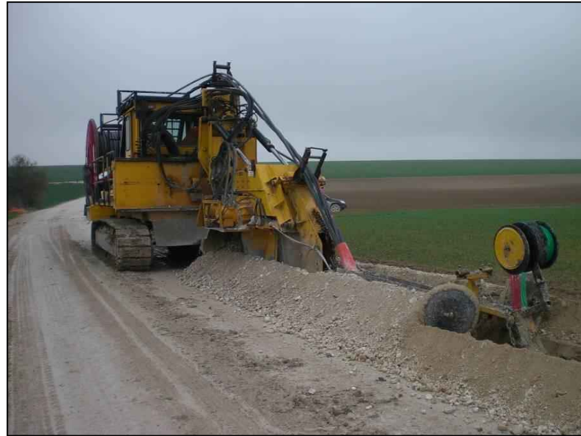
Photo 58 : Pose mécanisée de câbles électriques (Source : BE Jacquel et Chatillon)
