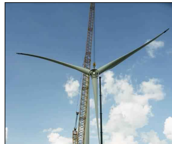
Photo 48 : Exemple de montage d'un rotor d'éolienne (Source : BE Jacquel et Chatillon)
