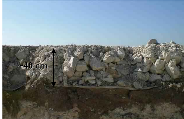
Photo 51 : Type de remblai utilisé pour le renforcement des chemins d'accès (Source : BE Jacquel et Chatillon)
